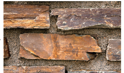
つげセメントで施工した壁 施工6ヶ月後でもほとんど白華が見られない
