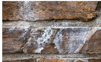
既存のエフロカット材を使用した壁 施工10日後に白華を確認
