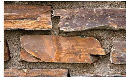
つげセメントで施工した壁 施工6ヶ月後でもほとんど白華が見られない
