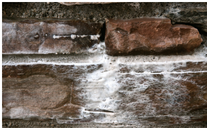
従来技術（1：3モルタル）で施工した壁 施工5日後に白華を確認
